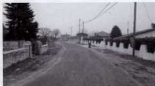
Voie neuve au Coustet après les travaux d'assainissement
