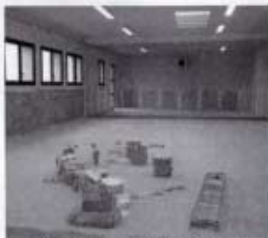
Travaux de finition au dojo du judo-club
