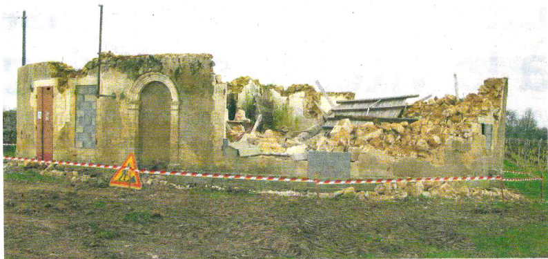
La démolition de la chambre ronde est inexorable. Il ne restera plus que la base. M. L.
