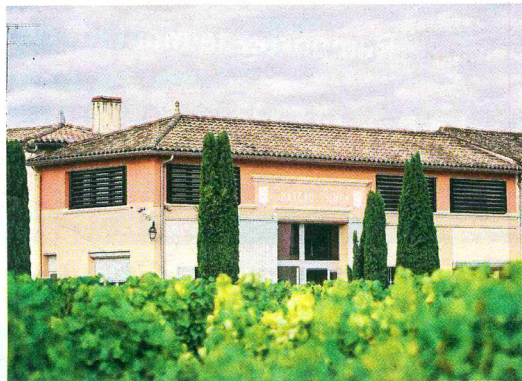
La façade du château Simon à Barsac, près du Ciron.
