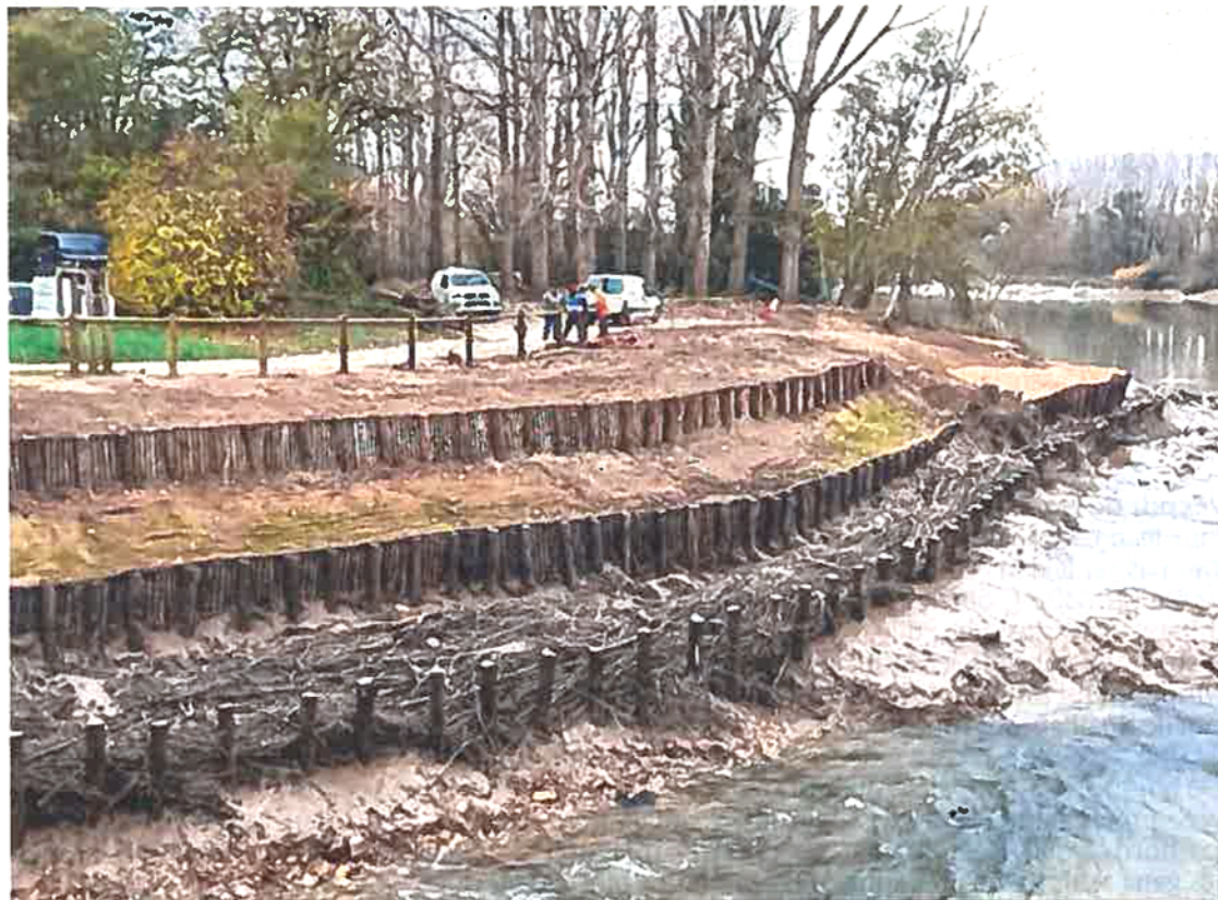
Rive gauche, un peigne en pied de berge est constitué de saules. Au-dessus, deux rangées de clayons constitués de ganivelles en châtaigner. SYNDICAT CIRON
