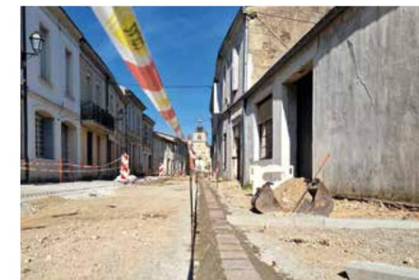
Une seconde équipe, 100m plus loin, construit le futur aménagement urbain. Après une remise en place et un compactage des sols, le futur emplacement des ouvrages est déterminé par des piquets en fer. Les altimétries sont ensuite réglées pour guider les eaux vers une grille de captation, en vue de ne pas avoir de retenues de cette dernière. Quelques caniveaux et grilles ont été rajoutés devant les seuils de portes les plus bas par simple sécurité. Puis les pavés et bordures sont posés.
